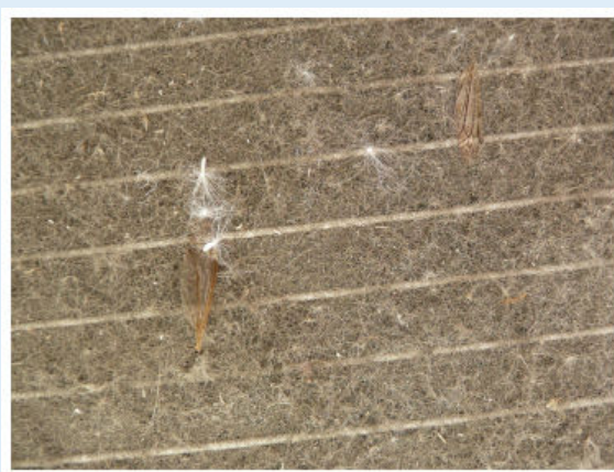
Exemple d'encrassement pour une installation urbaine
