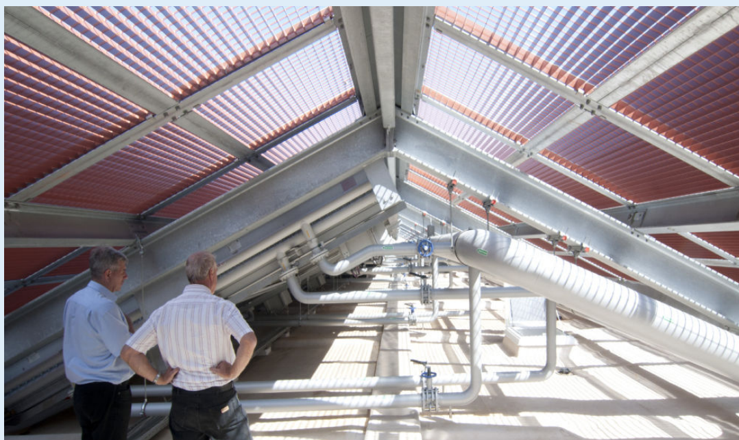
Vue sur les aéroréfrigérants après montage de la structure pare-vue
