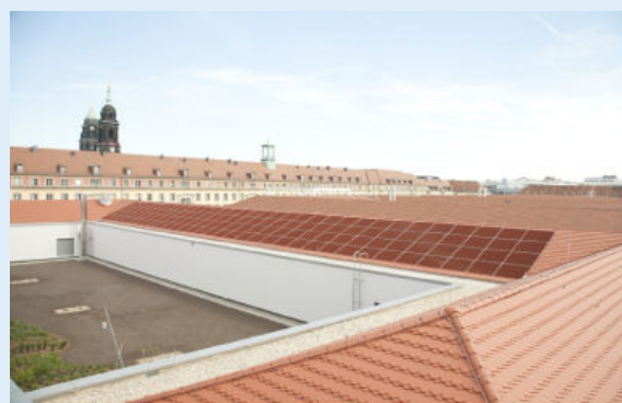
Vue extérieure du toit après le montage de la structure pare-vue
