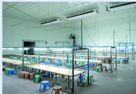
Evaporateurs doubles flux, pour salle de travail S-GBK : Ils garantissent la qualité des produits dans le domaine du commissionnement. Ces appareils ont été conçus spécialement pour les ateliers où ils assurent une adduction d'air silencieuse et sans courants d'air.
