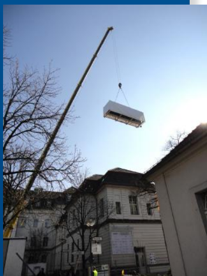
Une grue soulève les refroidisseurs de fluides sur le toit de l'unité de soins intensifs IPS1.
