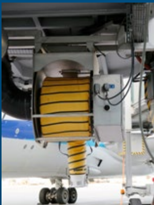
▲ Le tuyau de raccordement entre l'avion et les tubulures fixes est enroulé sous la passerelle passagers une fois l'unité PCA utilisée.
