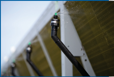
▲ L'aspersion peut être réglée individuellement pour toutes les sections.
