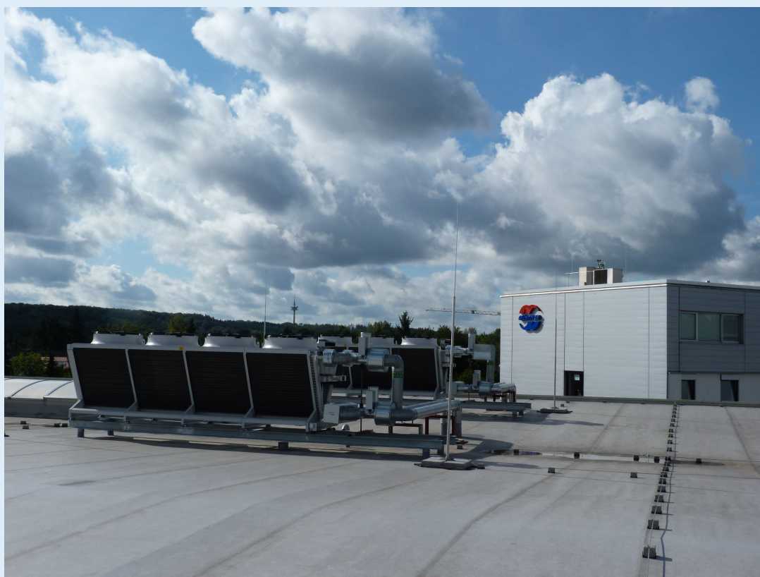
Les aéroréfrigérants utilisés sont des appareils Güntner de la série de produits GFW.
