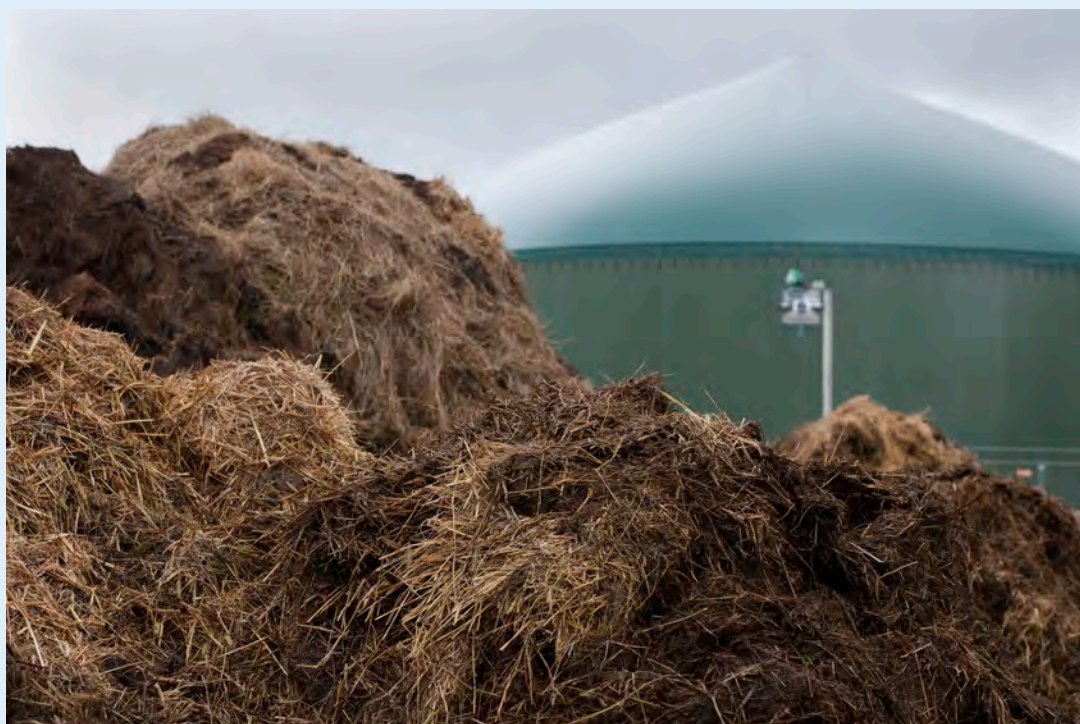
L'installation de biogaz à Trechwitz fonctionne avec du fumier et du lisier.
