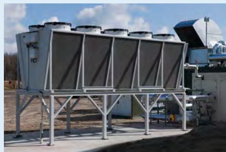
Spécialement conçu pour le secteur énergétique, le condenseur GVD refroidit le fluide de travail utilisé dans le processus ORC.
